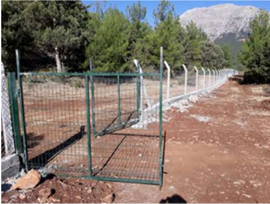
Şekil 8. Merkez Çevresinin Kafes Tel ile Çevrilmesi
