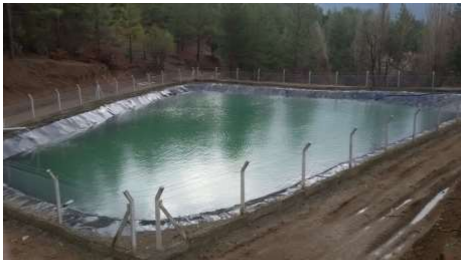
Şekil 6. POZMER Deresi ile İlgili Islah Çalışmaları ve EPDM Havuz Yapımı
