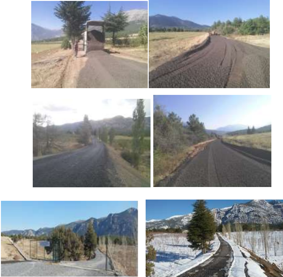
Şekil 9. Merkez Giriş Yolunun Asfaltlanması
