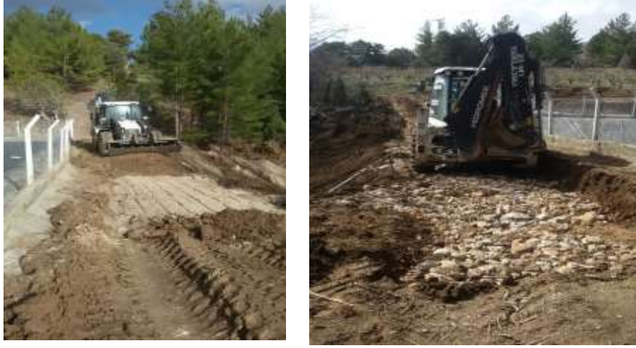
Şekil 7. EPDM Sulama Havuzu Seddini Güçlendirme Çalışmaları
